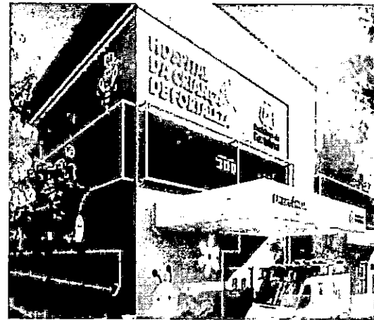
Hospital da Criança - Em construção
